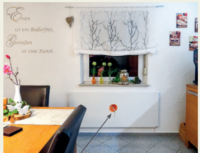
Platzierung der Leerdose mittig hinter der Infrarotheizung
